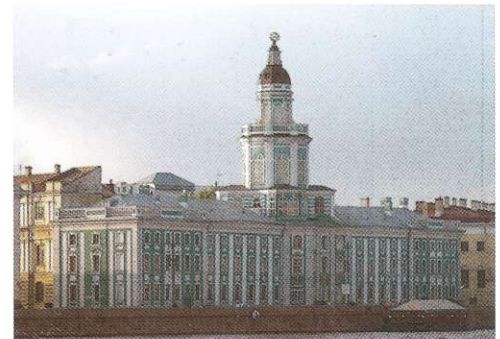
Здание Кунсткамеры сильно пострадало во время пожара 1747 года, происшедшего из-за того, что нартовскую механическую экспедицию лишили помещения. Вследствие этого все ее оборудование пришлось расставлять где попало.
