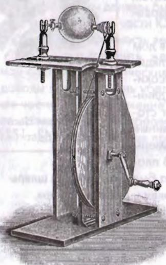
Светящийся шар на электрической машине Гауксби
