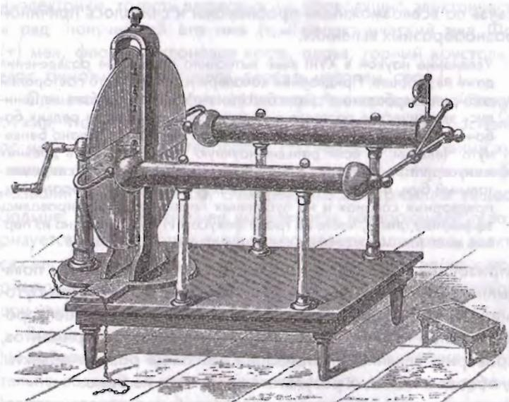
Электрическая машина с кожаными подушками, укрепленными на штативе
