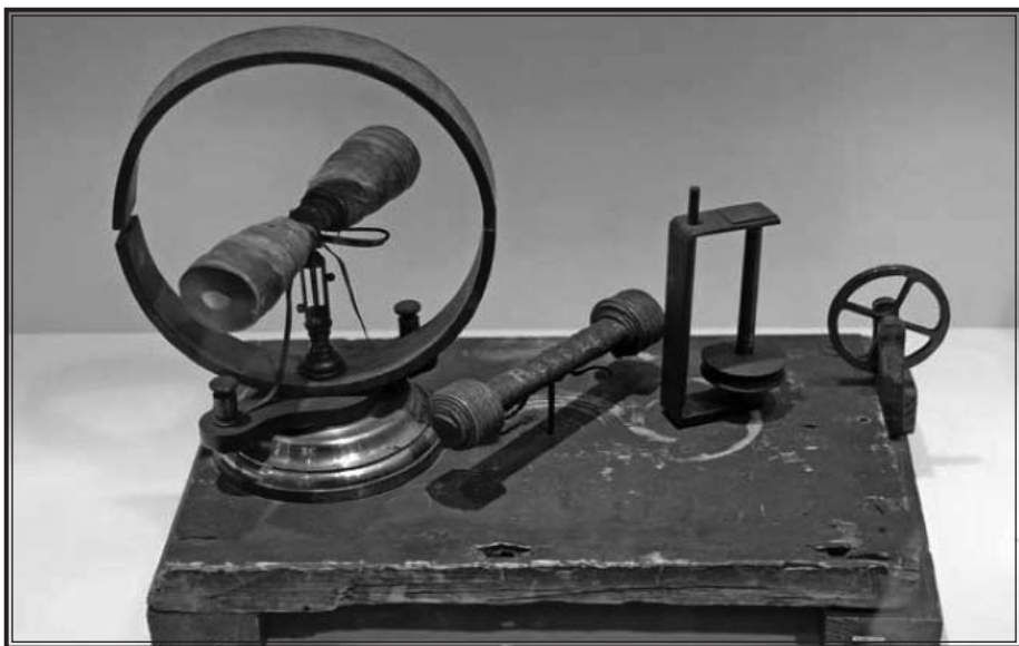
Рис. 8. Электромотор, созданный Джоулем в 1838–1841 гг. (экспонат Музея У. Хантера в Глазго, Великобритания, GLAHM No. 113365).
