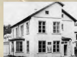
Здание управления ВНИИП
