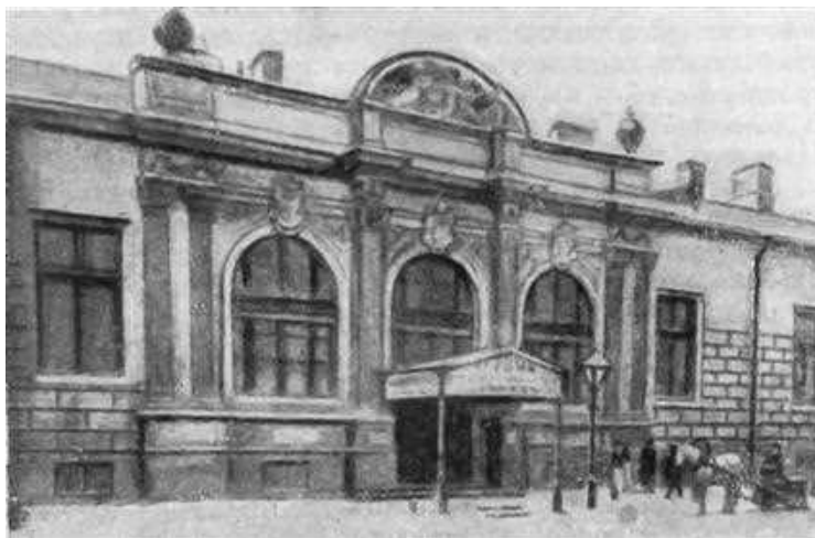
Общий вид здания в Соляном городке в С.-Петербурге, где проводились русские электротехнические выставки
